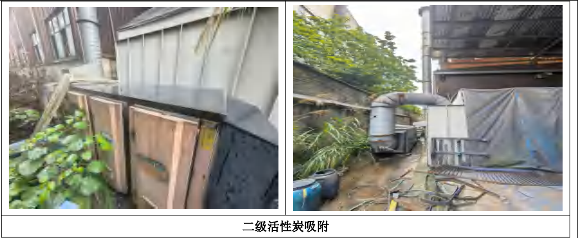
图3-2 项目废气处理设施现场照片
