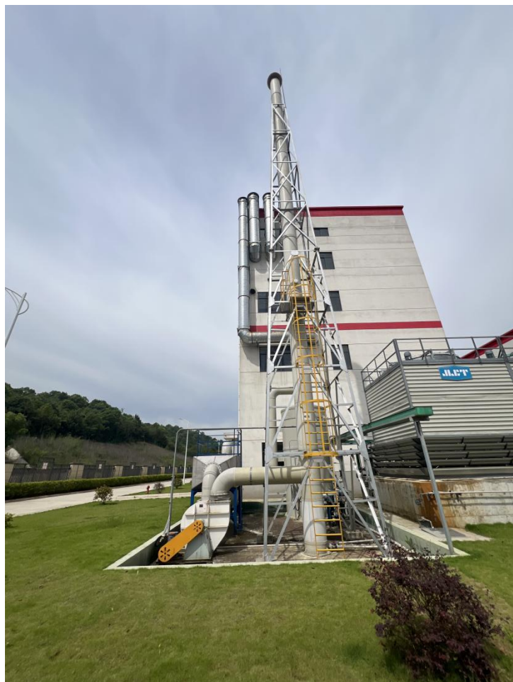
废气处理装置（水冷+水喷淋+树脂吸附）
